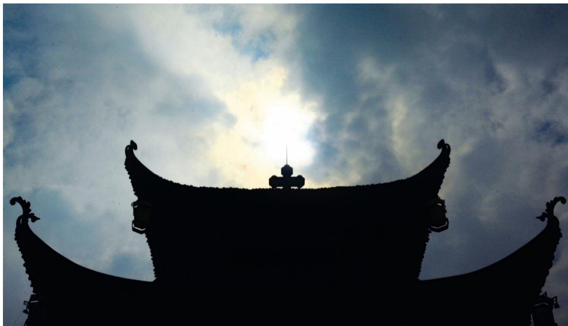
Hình 2.6.7. Góc nhìn hướng nam từ sân nhà thờ Chính
