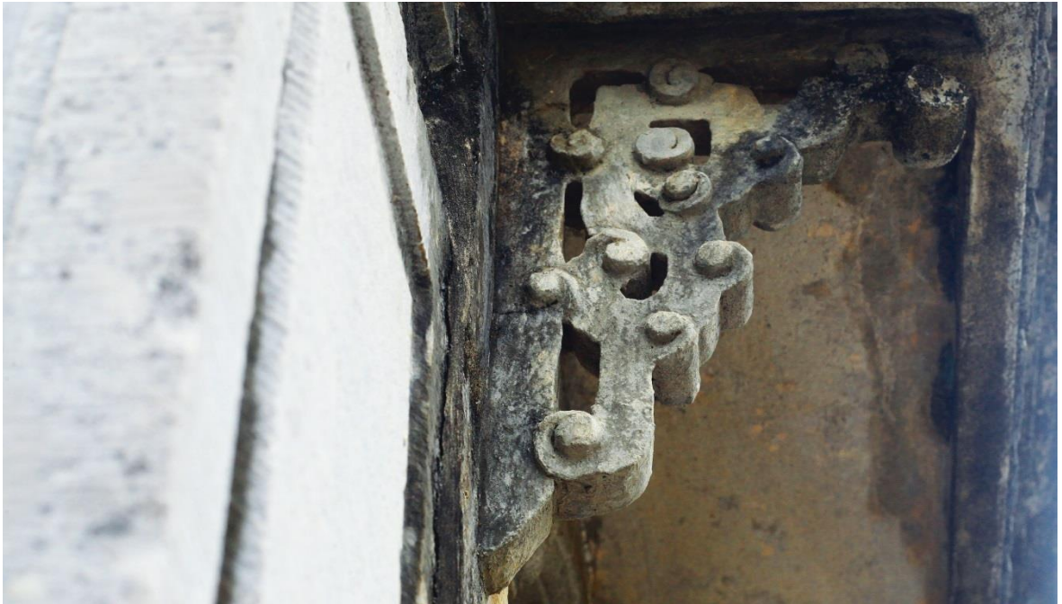
Hình 2.2.27. Chi tiết đắp vữa
